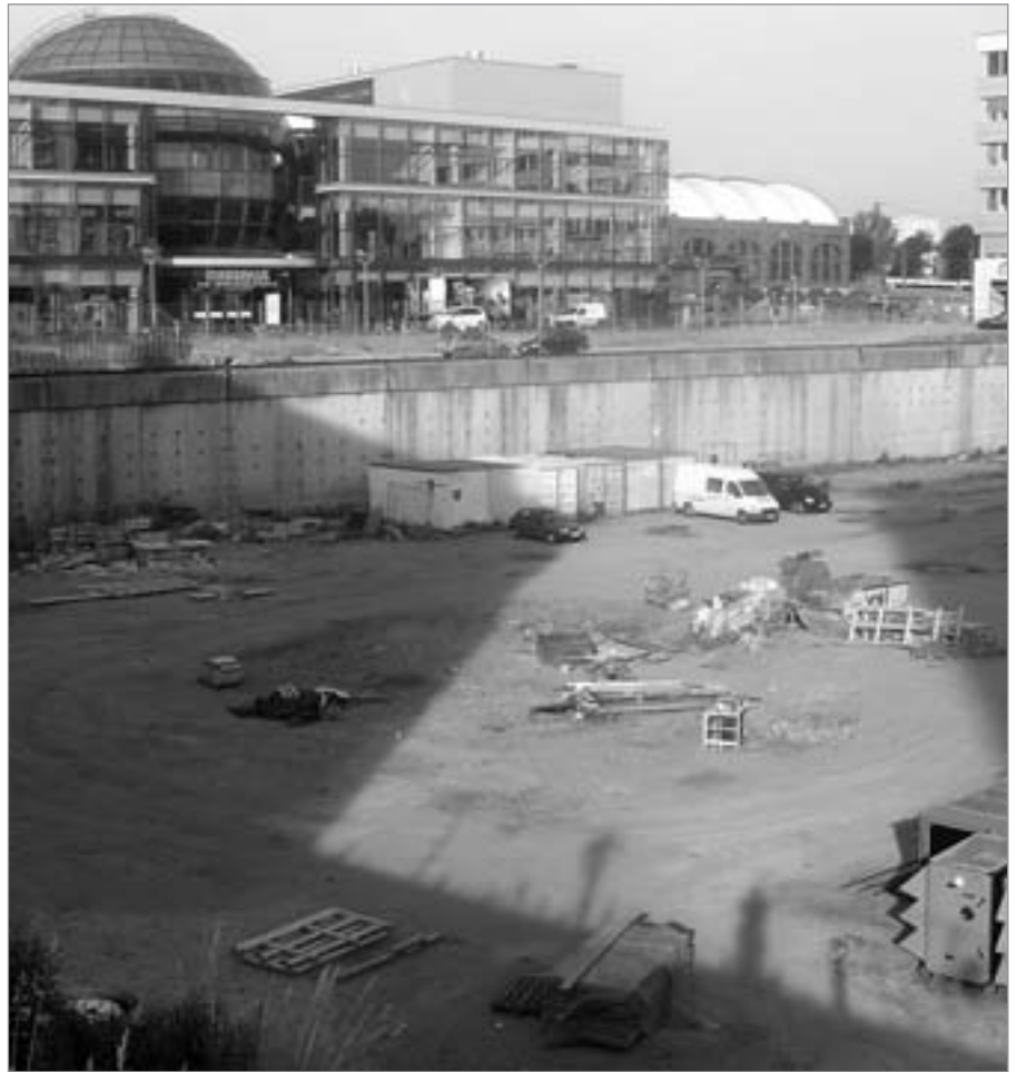
Baugrube am Wiener Platz (MK5)
